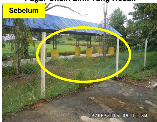
Gambar 4.14 Pagar Chain Link Yang Rosak
