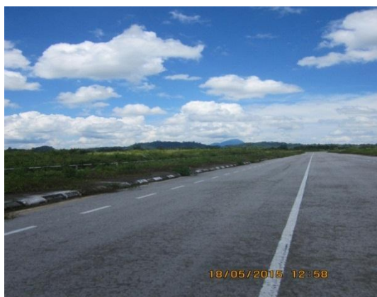
Gambar 1.2 Pembinaan Jalan Raya
