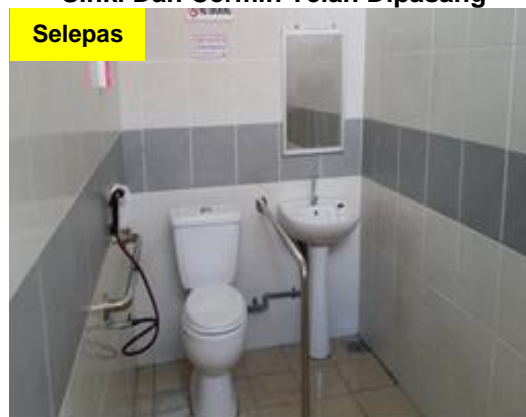
Gambar 4.8 Sinki Dan Cermin Telah Dipasang
