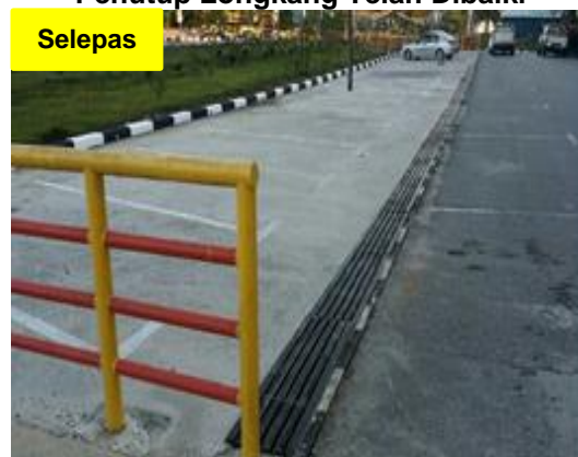
Gambar 4.11 Penutup Longkang Telah Dibaiki
