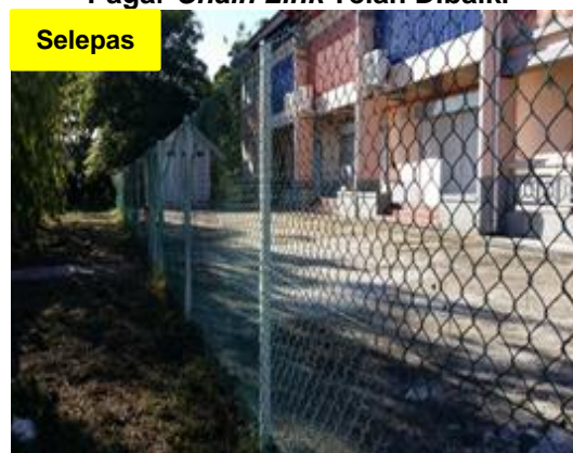
Gambar 4.15 Pagar Chain Link Telah Dibaiki
