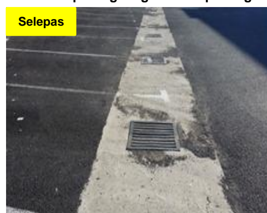
Gambar 4.13 Penutup Longkang Telah Dipasang
