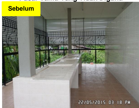
Gambar 4.16 Pasar Tamu Yang Tidak Diguna
