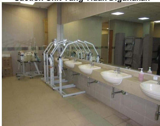
Gambar 6.6 Sebahagian Pole Lifting Dan Suction Unit Yang Tidak Digunakan
